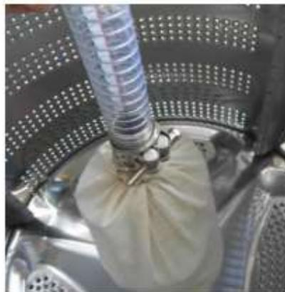
中古の洗濯機の回転槽を利用した取水口保護
