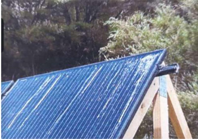
この例では、農家は 70m ヘッドまでポンプで汲み上げていましたが、PV パネルを 2 枚しか設置していませんでした。設置ガイドでは、このヘッドには 4 枚のパネルが必要です。また、鳥の糞でパネルが汚れるのを放置していました。
